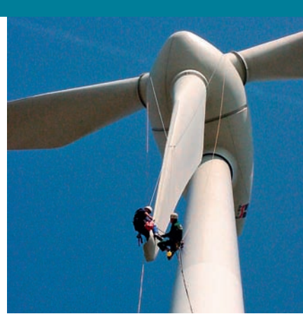
Seite 27: Erneuerung der Erosionsschutzfolie im Bereich der Anströmkante
