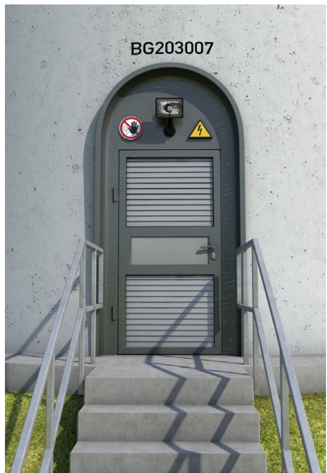
Abb. A13-7 Kennzeichnung WEA (Anlagennummer)
