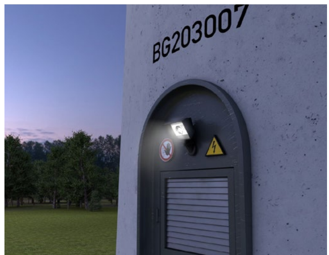
Abb. B4-1 Zugang mit ausreichender Außenbeleuchtung
