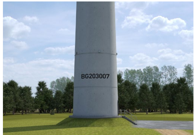
Abb. A13-6 Kennzeichnung WEA (Anlagennummer) wegseitig
