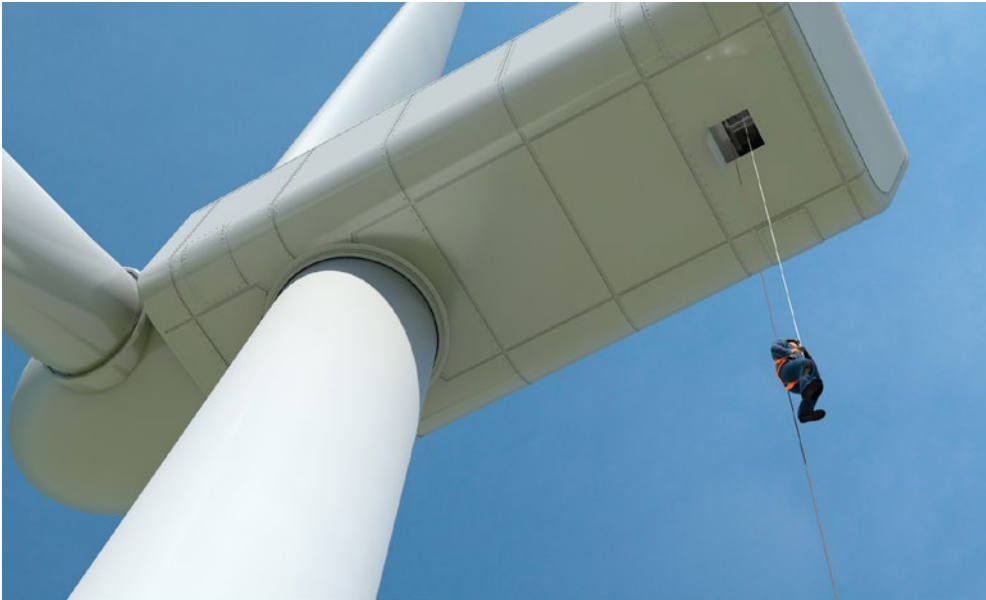
Abb. A13-5 Abseilen aus dem Maschinenhaus (Übung)
