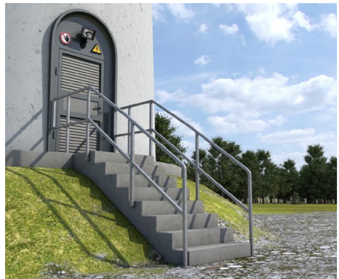
Abb. B1-1 Sicherer Zugang zur Anlage
